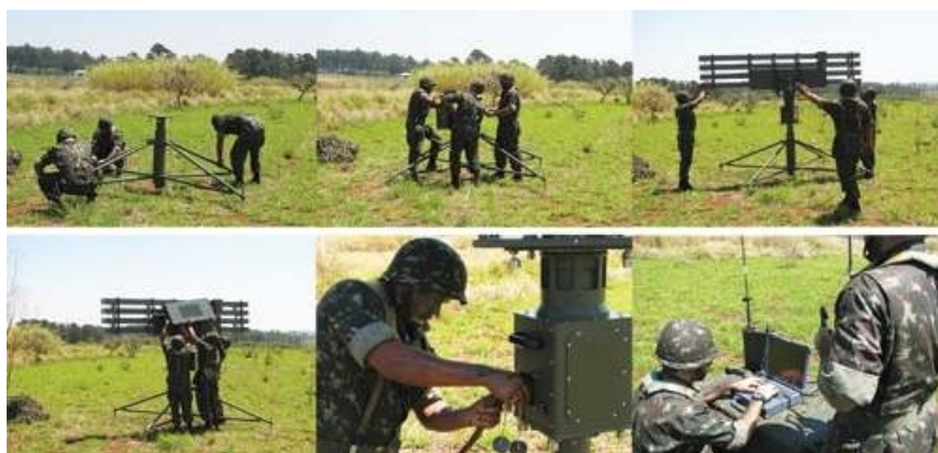
Figura 7 – Montagem do Radar Transportável SABER-M60 Fonte: BRADAR, 2015.
